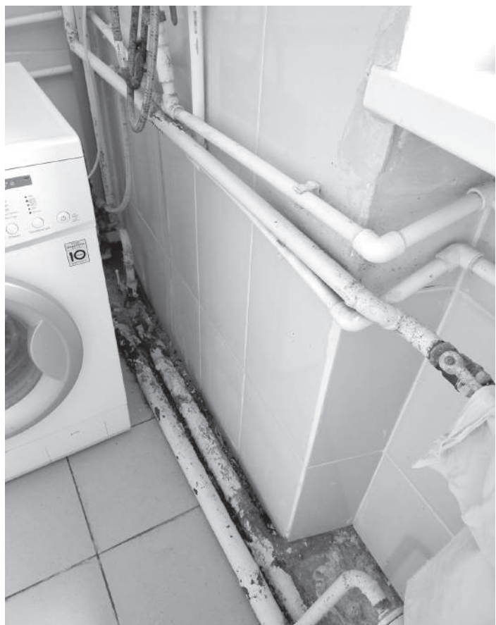
Отыгран контракт на ремонт труб холодного водоснабжения
