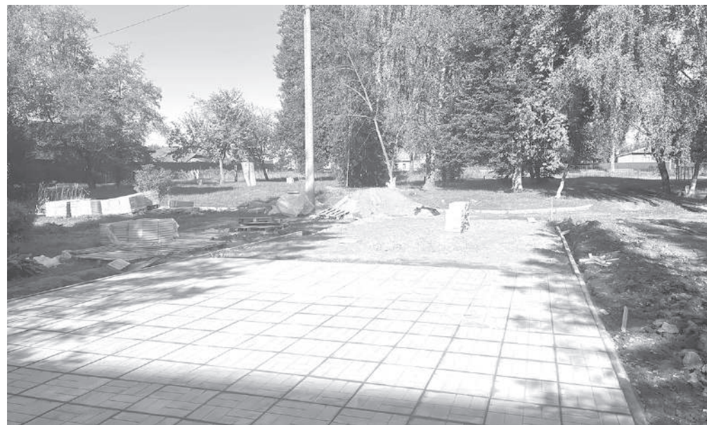
Дорожка, ведущая к обелиску, почти готова. К 1 сентября работы планируют завершить полностью
