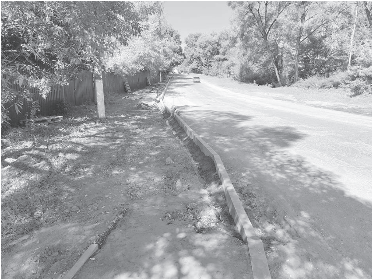
После установки бордюрного камня подрядчик займётся планированием тротуара на подъеме в горку
