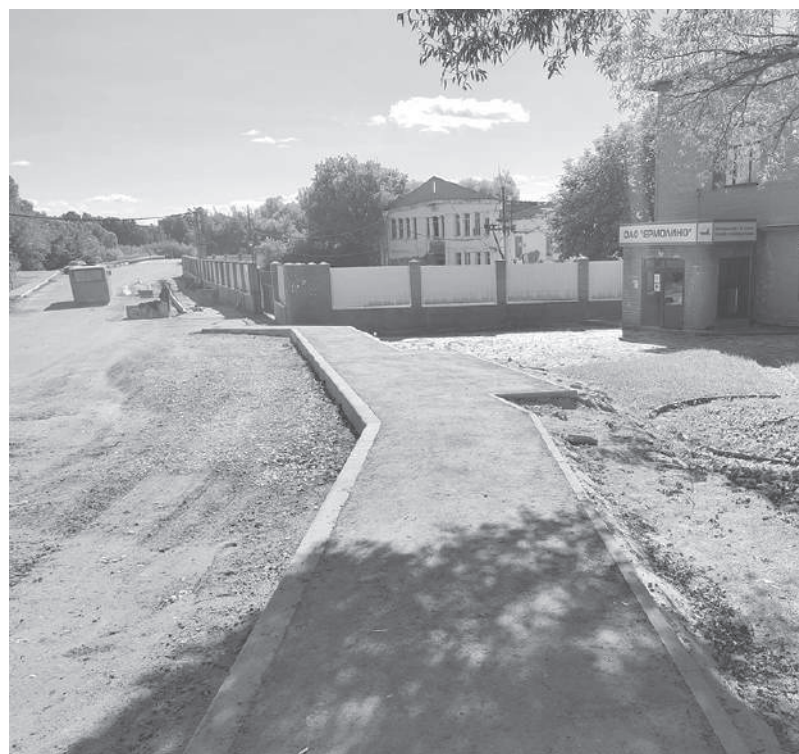
Место для автобусного павильона уже готово
